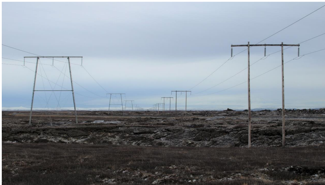
Mynd 3. Mismun á haflengd og umfangi nýrrar byggðalínu (t.v.), Kröflulínu 3 og eldri, Kröflulínu 2 má sjá hér á Mývatnsöræfum (ljósm. Hjalti Jóhannesson).
