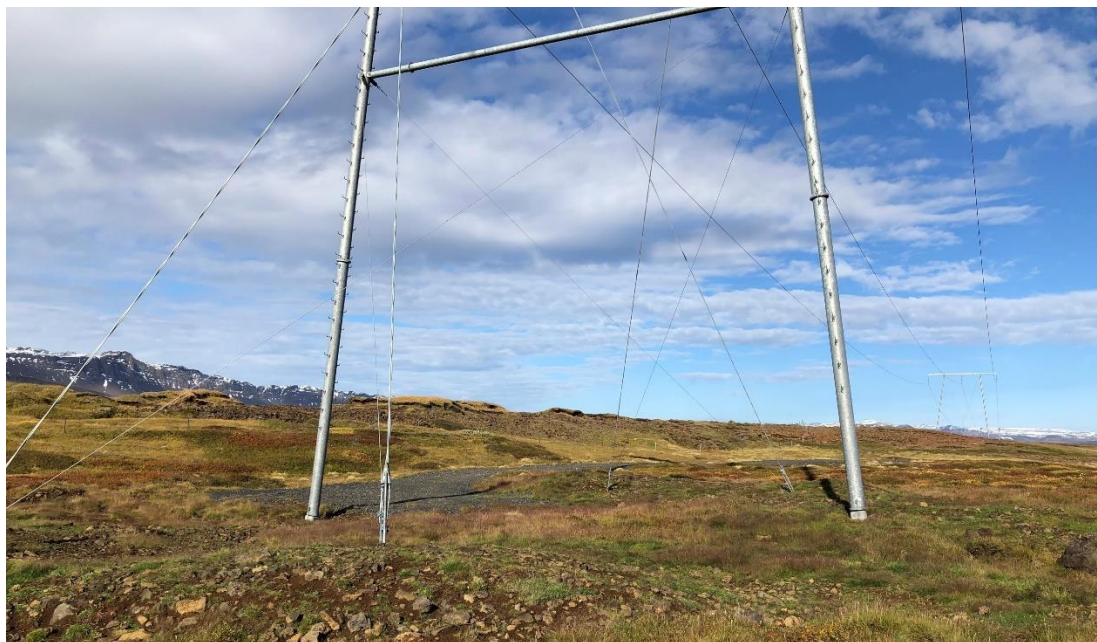
Mynd 2. Frágangur við möstur Hólasandslínu 2 (áður Þeistareykjalínu 1) milli Hólasands og Bakka við Húsavík þremur árum eftir framkvæmd (ljósm. Landsnet).
